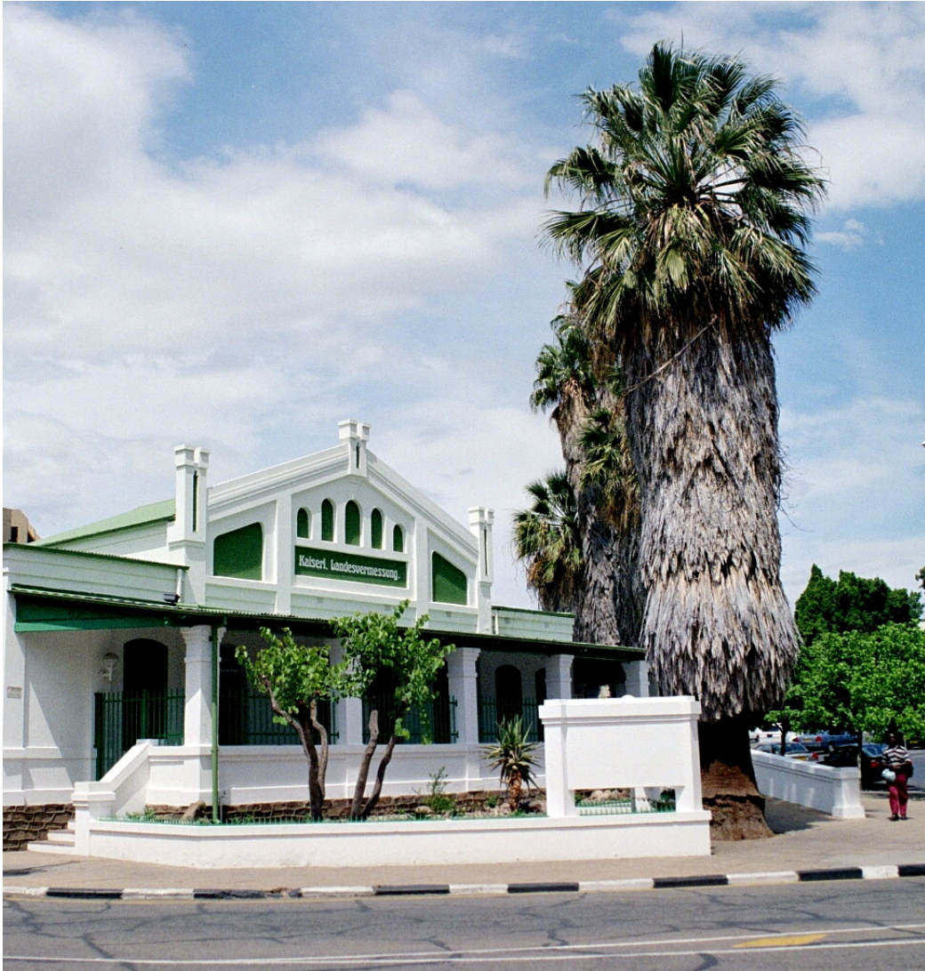
Abb. 41: Heute noch erhaltenes Dienstgebäude der ehemaligen „Kaiserl. Landesvermessung“ in Windhuk (Quelle: Foto von Johannes Flemisch, Oberammergau; aufgenommen in 2006)
