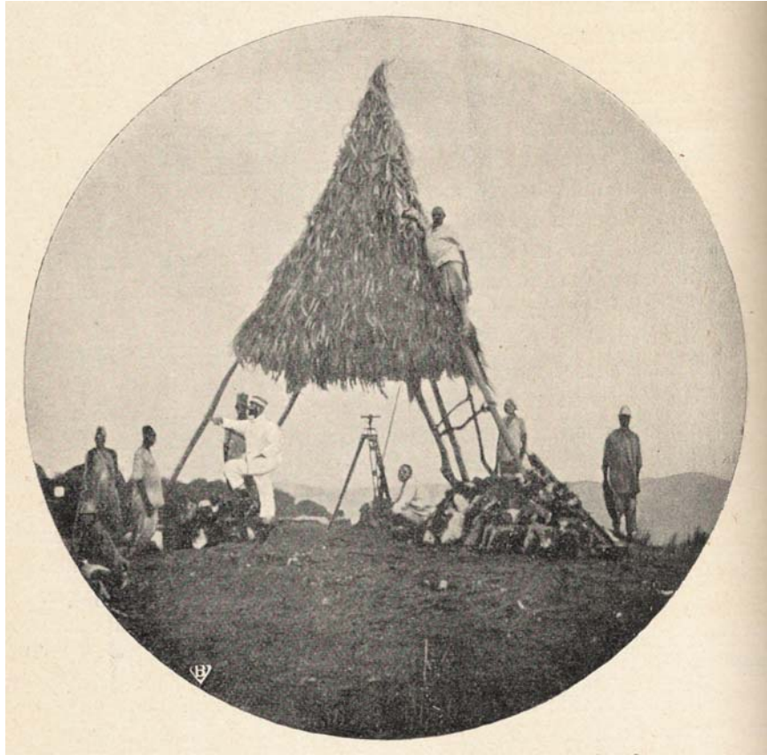
Abb. 18: Signalisierung eines Dreieckspunktes am Kiwusee (Quelle: FONCK, 1910; S. 230)
