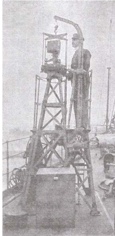
Abb. 57: Aufstellung eines Phototheodoliten an Bord des ersten modernen Vermessungsschiffs „Planet“ (Quelle: DKZ 1907, S. 127).
